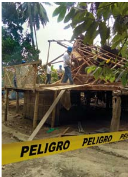
Abbrucharbeiten an einem Holzgebäude in Ríochico, Manabí, Ecuador, 2016 (Foto: Thorsten Kallnischkies)
