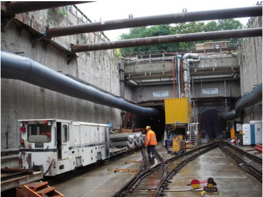
Tunnelröhren des U5-Lückenschlusses (Foto: VBGU/Alisch)
